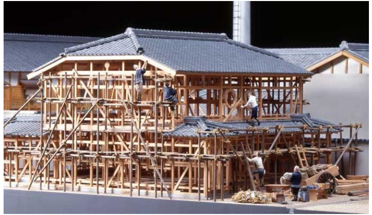
建設中の長屋
